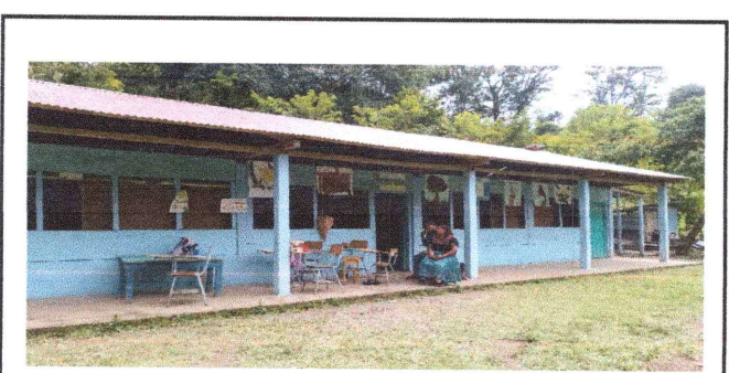
Foto 5: sustitucion de ventanales de madera a metal.
